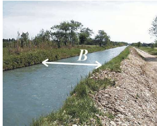
FIGURE 4.3 – Canal à surface libre – la largeur B se mesure à la surface («miroir»).
