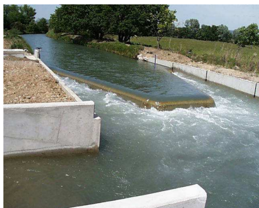
FIGURE 4.41 – Déversoir en bec de canard – Salon de Provence
