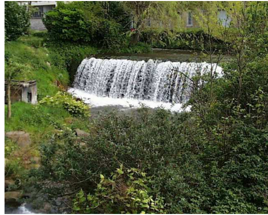
FIGURE 6.9 – Seuil en rivière (section de contrôle)
