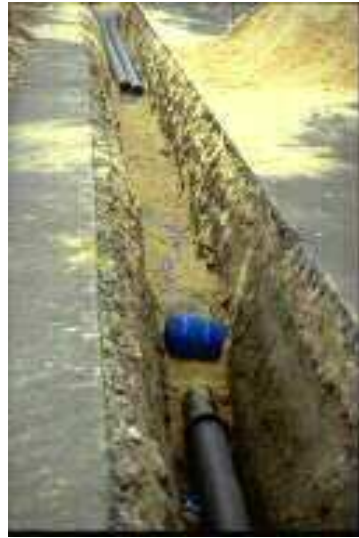
FIGURE E.4 – Pose d'une conduite d'eau potable (Photo Le Bars - Cemagref)
