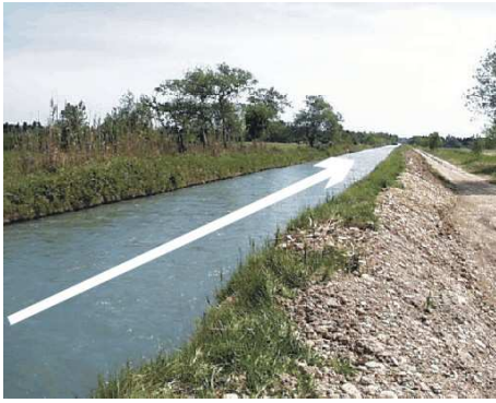
FIGURE 1.10 – Canal à surface libre – Vue à l'échelle d'un aménagement; à cette échelle, on voit clairement le mouvement d'ensemble, donc l'axe de l'écoulement qui peut être considéré comme monodimensionnel.
