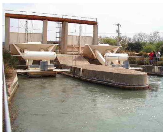
FIGURE 4.42 – Vannes à niveau aval constant (AVIS) – Lamanon
