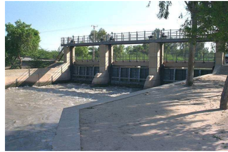
FIGURE 4.34 – Vannes de fond noyées, canal primaire de Chashma Right Bank Canal (Pakistan)
