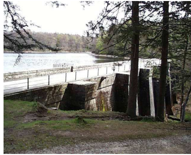
FIGURE E.2 – Barrage poids, les contreforts à l'amont assurant la stabilité de l'ouvrage
