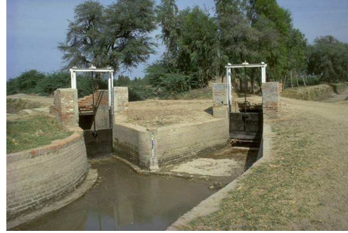
FIGURE 4.31 – Vannes verticales à glissières dans un réseau d'irrigation ; les ouvertures respectives permettent de contrôler le débit envoyé dans chaque branche du réseau mais également de contrôler le niveau dans le bief amont de la diversion
