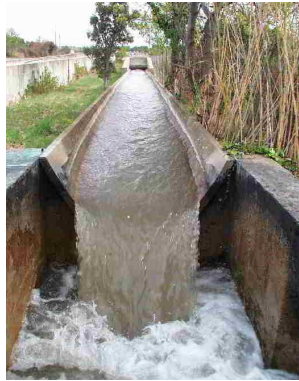
FIGURE 4.19 – Ce coursier est à pente faible et le régime normal est fluvial. On est donc dans le cas d'un canal à pente faible. La zone que l'on peut observer est en régime fluvial, donc contrôlée par l'aval. A l'aval, la chute d'eau fait décroître le niveau d'eau : nous avons donc une courbe de remous F2 qui converge rapidement vers le régime uniforme à l'amont.
