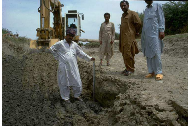
FIGURE 5.1 – Sédiment en tête d'un canal d'irrigation (Pakistan), après une saison d'irrigation.
